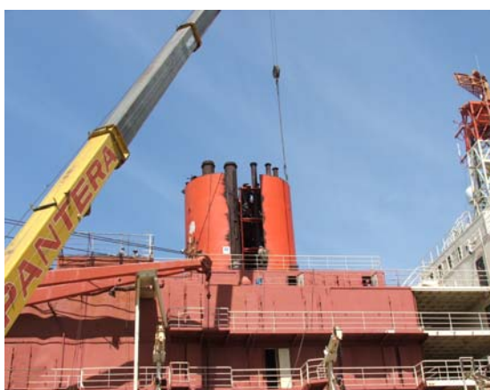
Desmante de Chimenea
