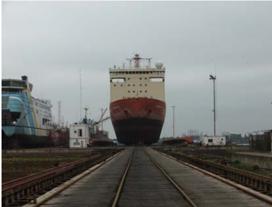
Entrada al Syncrolift
